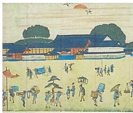
旧加賀藩上屋敷 御守殿門
