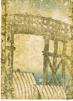
架橋当時の淀屋橋 (「淀屋形金鶏新話」より)
